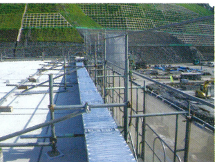
均熱笠木ヒーティング施工状況
