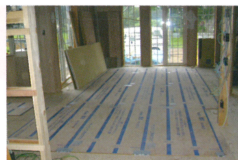
パネルタイプ施工状況
