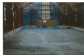
埋設式（温水）施工状況
