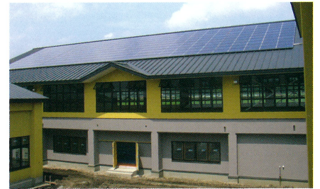
30kw システム施工状況
