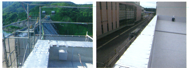
特殊形状（ラジアル折板）屋根にも施工可能。
