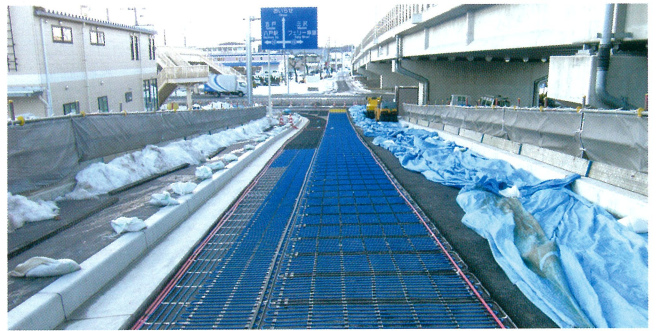
エコプロヒートシステム 施工状況
