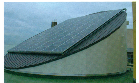
10kw システム施工状況
