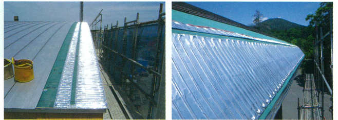
均熱ルーフヒーティング施工状況
